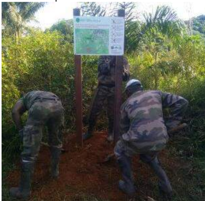
Pose du panneau à l'accès Cotonnière © CA (MGM)
