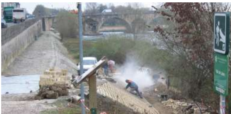
Réfection des perrés des quais Foch à La Charité sur Loire
