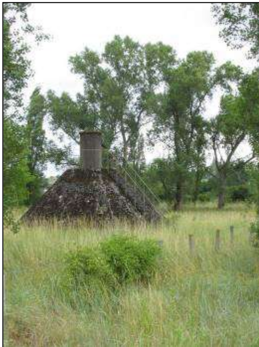
Un des puits de captage dans la nappe alluviale
