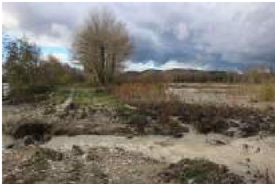
Brèche dans la digue le 25/11 ©T.FOCH-CCVD
